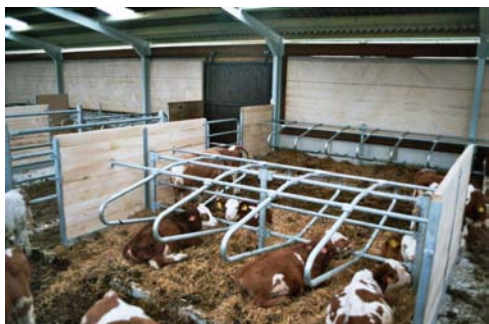
Ukázkový boxový teletník, bohužel chybou chovatele se zamezuje příčné provětrání vysunutou plachtou.
