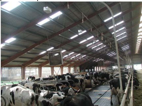
foto 03: Účinnost této kombinace – ventilátory a „tzv. sprchy“ (nevhodné otáčivé zmlžovací trysky i umístění) je mizivá.
